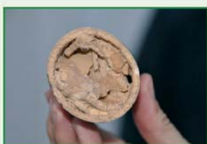
Entrada a batería contadores.
