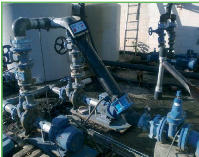
ECOPLASTIC AMBIENTAL. Los Palacios y Villafranca (Sevilla) Protección maquinas de extrusión de plástico
