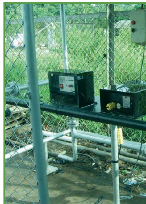
ECOPETROL COLOMBIA CAMPO PAYOA. Protección sistema de enfria- miento tren de compresores
